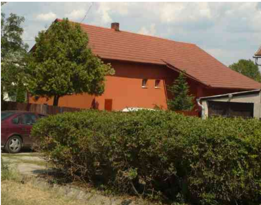
Csapadékelvezető és járda közé telepített sövény
