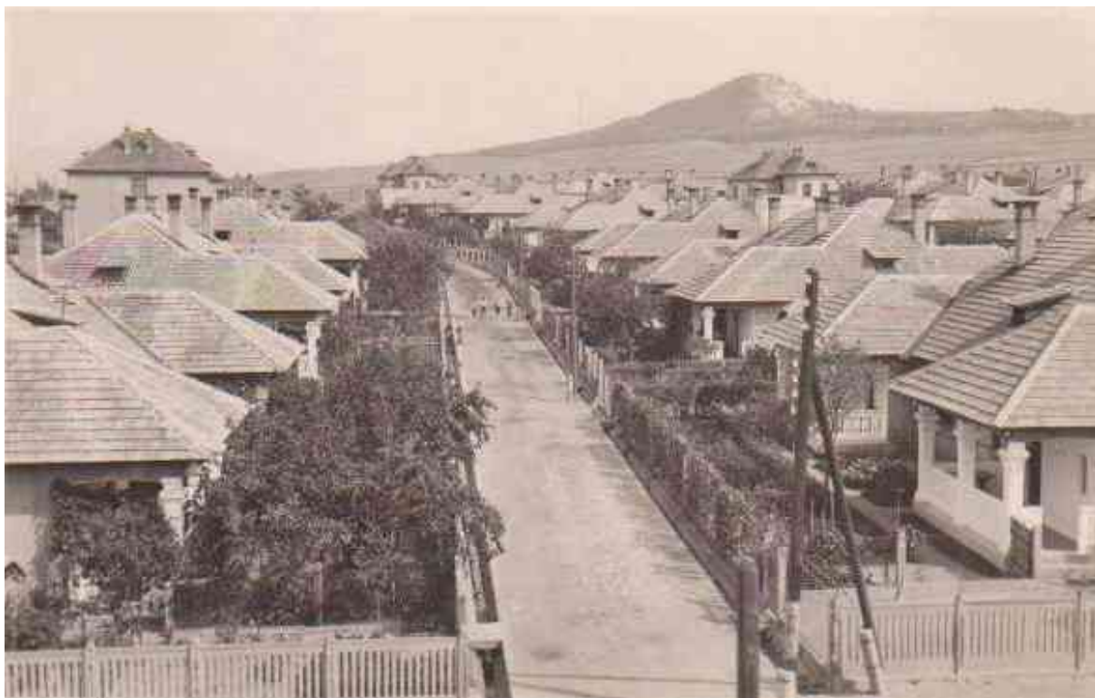
A '20-as évektől épült „4-es bányásházak” eredeti állapotban
